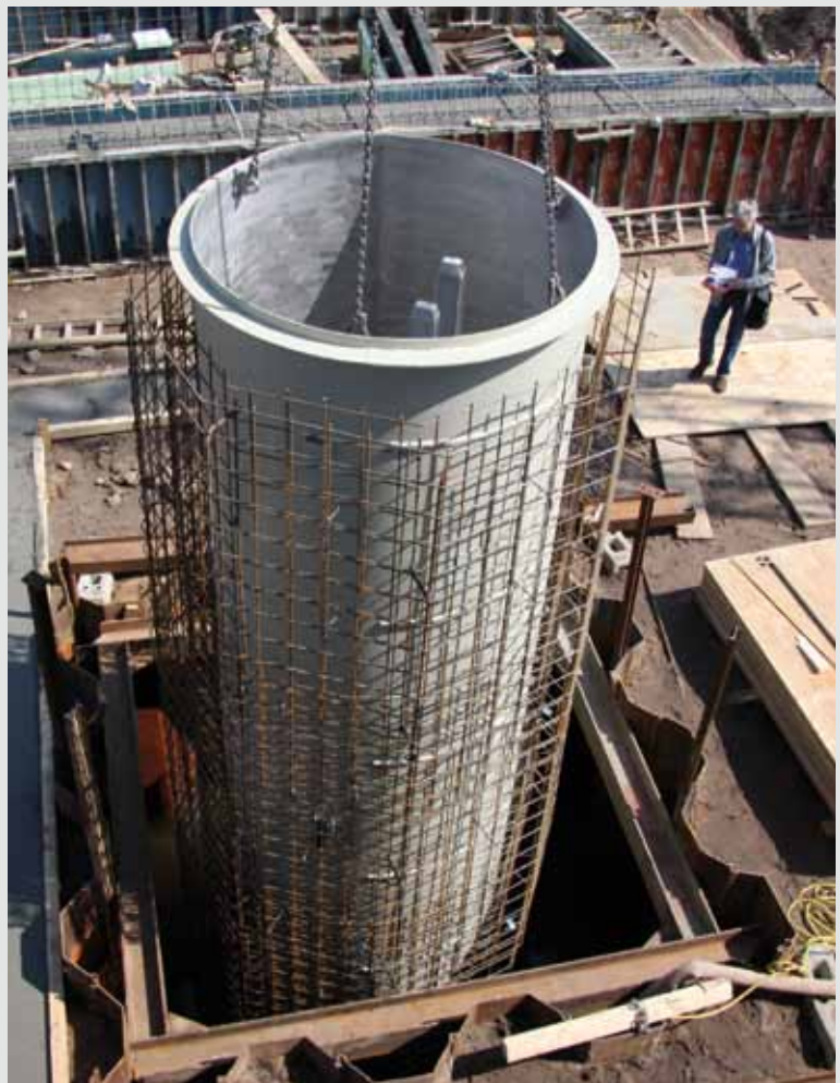
Der Edelstahlbehälter mit Armierungskorb wird in die Baugrube hinabgelassen.
